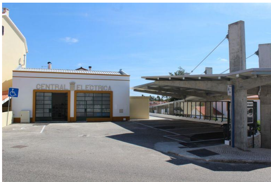
Figura 30 | Terminal rodoviário de Vila de Rei
