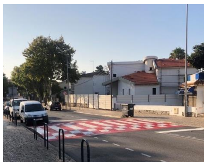
Passadeira sobrelevada e com diferenças de pavimento e cor junto a escola (Cascais)
